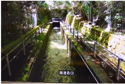
芦ノ湖側給水口水路
