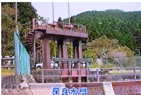
芦ノ湖深良水門(四ッ留水門)
