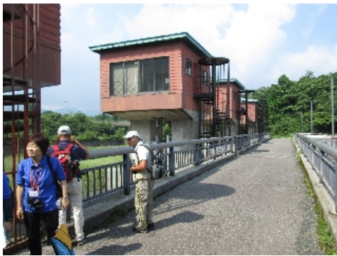
芦ノ湖早川水門(逆川水門)
