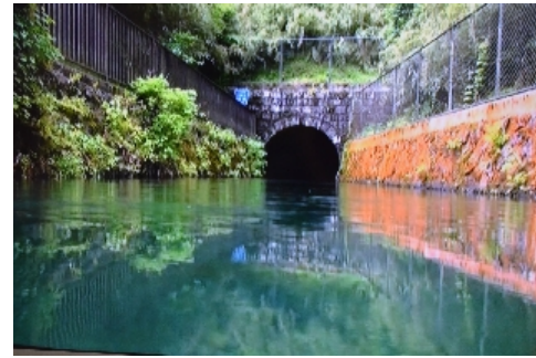
裾野市深良地区隧道出口
